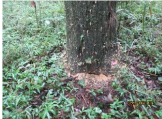
虫くいの後は木くずが出ています
